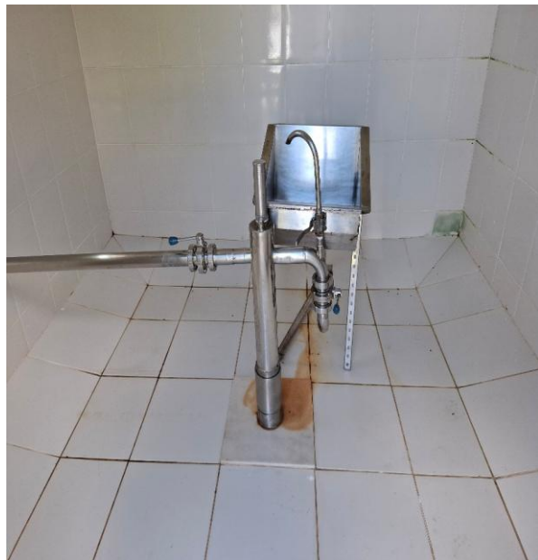
Captação do Poço
