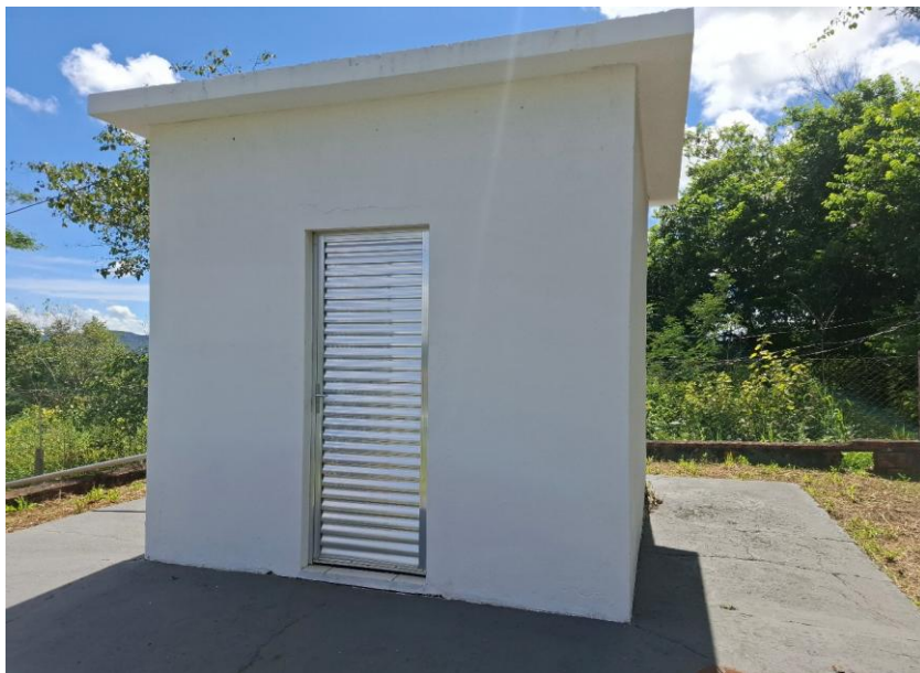
Casa de Proteção do Poço
